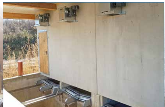
Antriebe an Wand über Abwurf - Unterflurschieber
