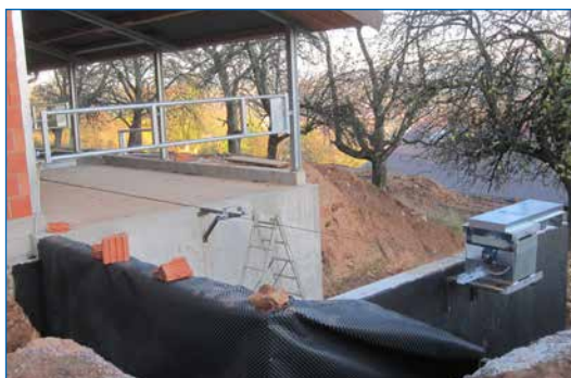
Abwurf auf tieferliegende Mistplatte
