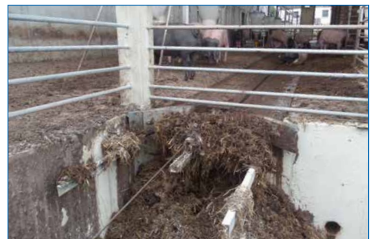
Faltschieber über Abwurf
