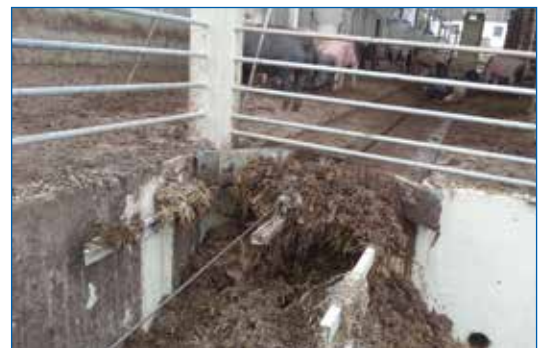
Faltschieber über Abwurf
