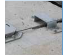
Anschlagbock für Schieber, verzinkt (Best.-Nr. 121.0806)
