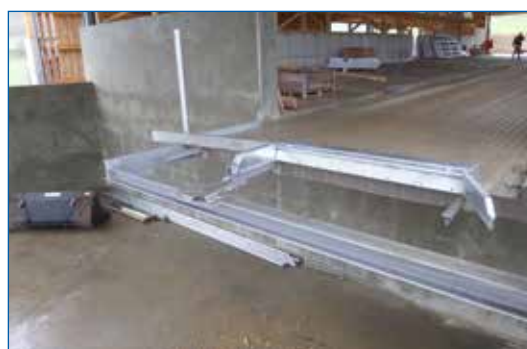
Abwurf Tretmist auf tieferliegende Mistplatte
