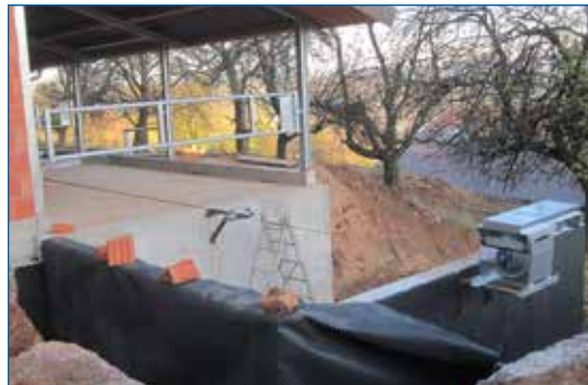
Abwurf auf tieferliegende Mistplatte
