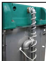
Труба тупикового водопровода и клапан обмотаны термошнуром
