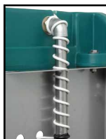
Труба тупикового водопровода и клапан обмотаны термошнуром
