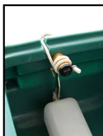
Клапан обмотан термошнуром
